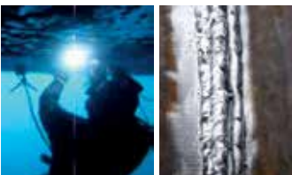
Порошковые проволоки, подводная сварка и вид стыкового многослойного шва труб толщиной 21,3 мм
